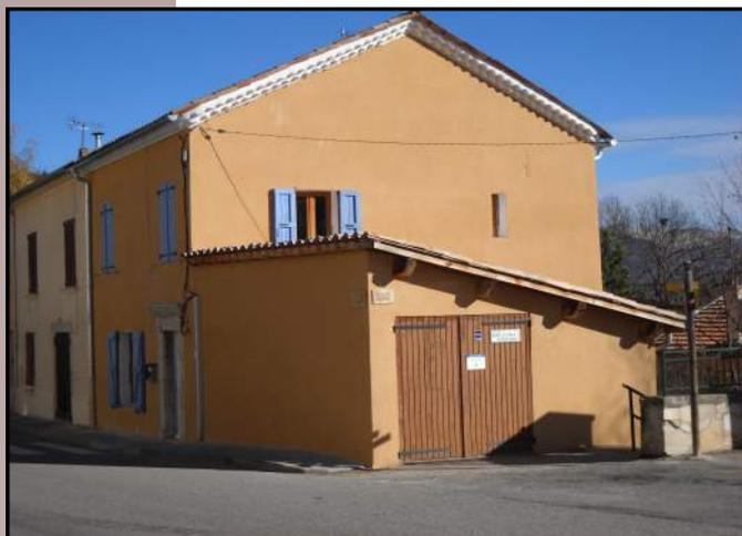
Les travaux de réfection des façades du bâtiment communal de la Cure entrepris en ce début d'automne par L'Entreprise ROUX s'achèvent. Une reprise de la toiture a également été faite avec réfection de la cheminée, des génoises et collage des tuiles.
